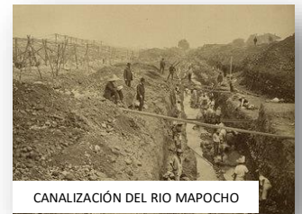
CANALIZACIÓN DEL RIO MAPOCHO
